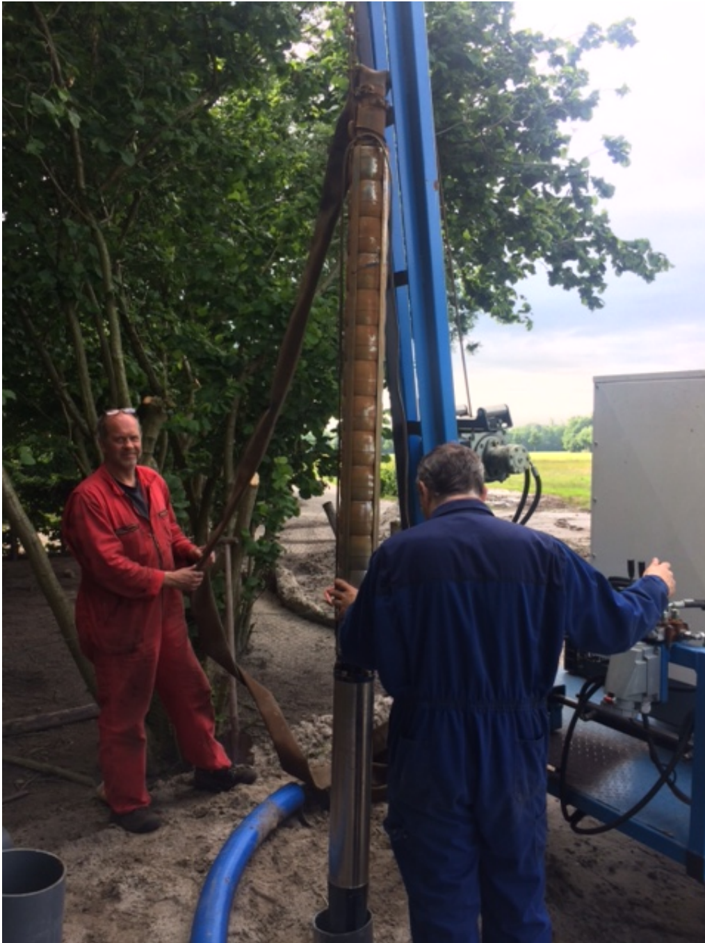
Foto 3: De elektromotorpomp wordt in de grondwaterput gebracht
